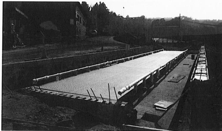
**BASCULA AK BASCULAS DE 22 m, 100% ACERO CON RIEL GUIA E INSTALADA EN UNA SEMI FOSA**
