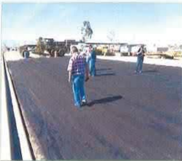
Reconstrucción de 10,500 m 2 de concreto asfáltico en Calle Isla de Cedros.
